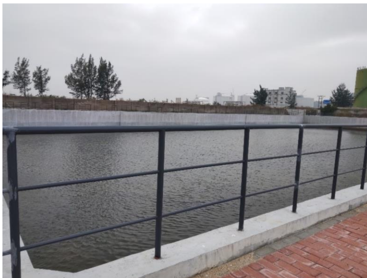
南迳湾库区事故应急池
