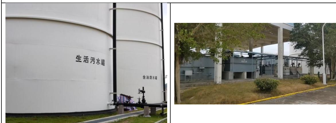
污水处理站（铁炉湾库区）
