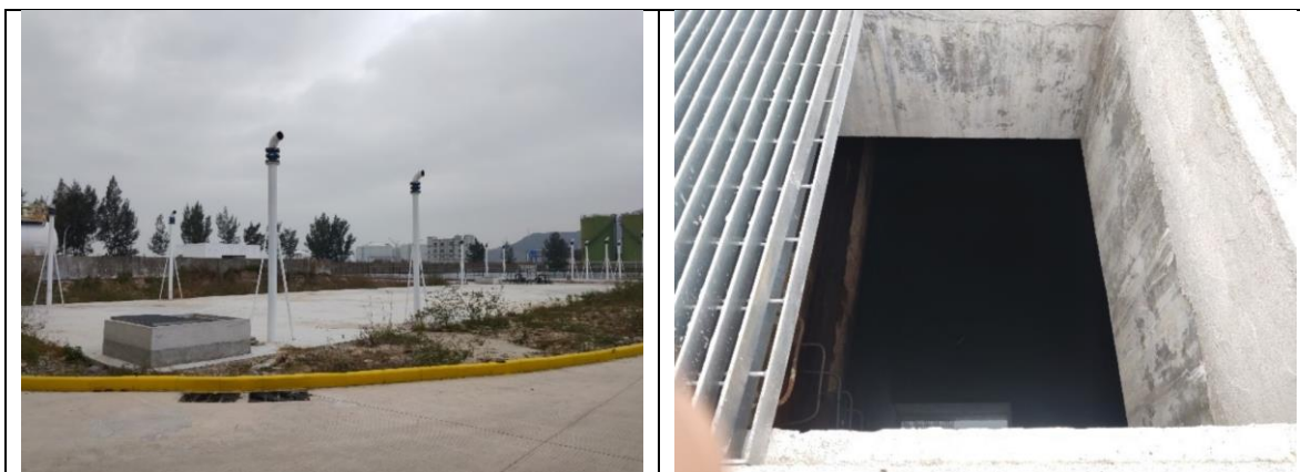
本项目新建污水收集池（南迳湾库区）
