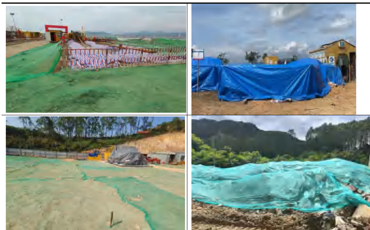
施工期土壤覆盖
