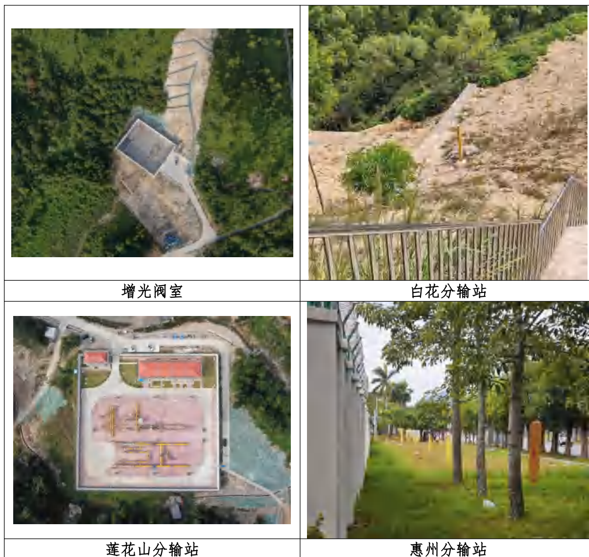
图 5.2-5 站场站内及周边植被恢复
