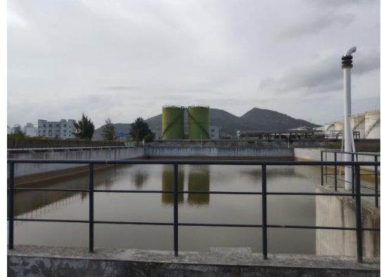
南迳湾库区事故应急池
