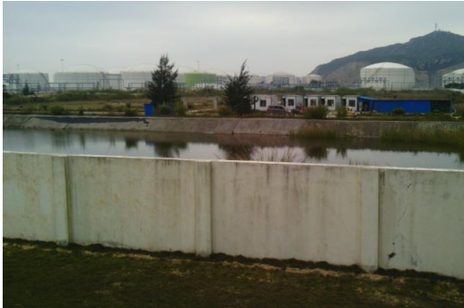
铁炉湾库区事故应急池
