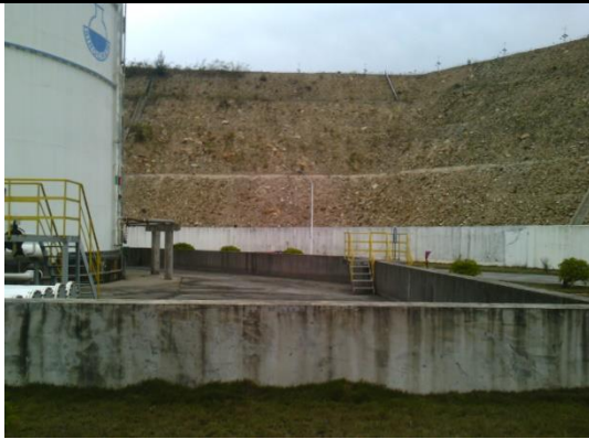
储罐区围堰
